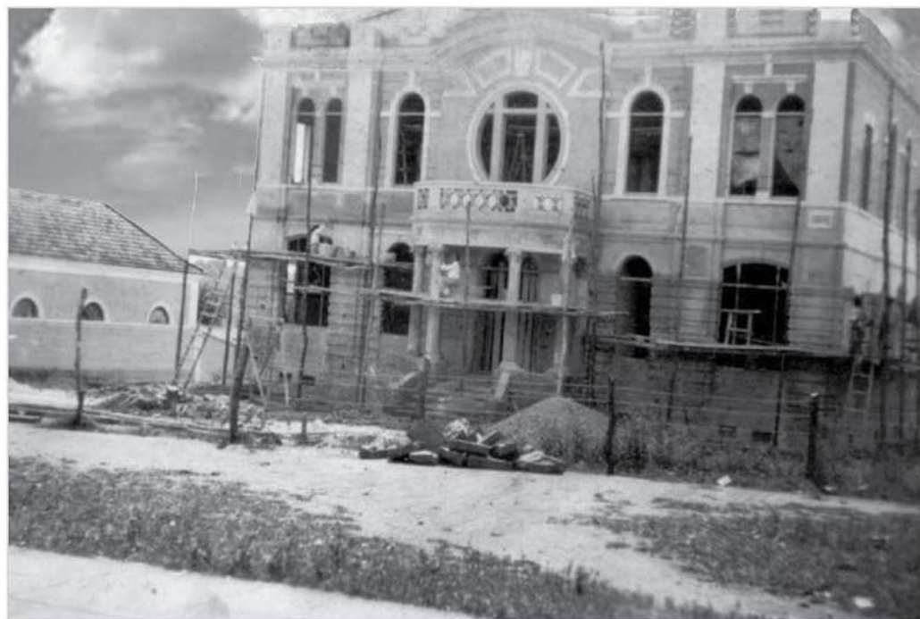
Obras de Construção da Camara Municipal de Batatais. Em fevereiro de 1927, o Edifício foi inaugurado. (Fonte: Acervo Digital de Batatais.)
